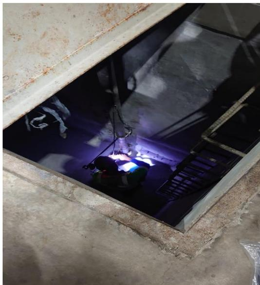
3. Setelah diperiksa, Sensor level low Waste water sudah diganti dengan yg baru, Sensor High sudah verifikasi juga (Avo meter dan Hmi Signal)
